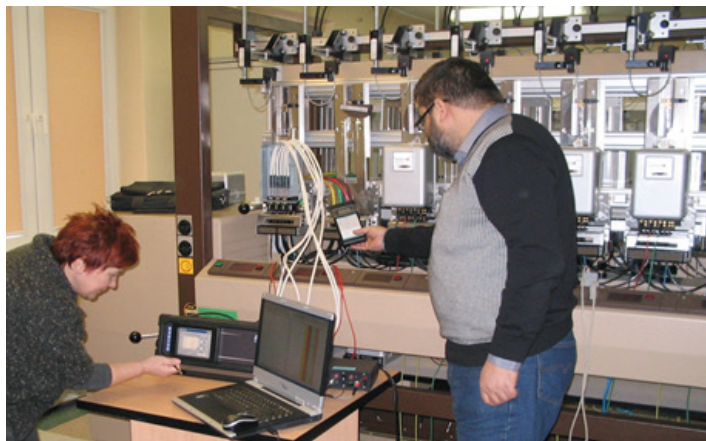
Rys. 10. Zmodernizowane stanowisko do wzorcowania liczników energii elektrycznej
