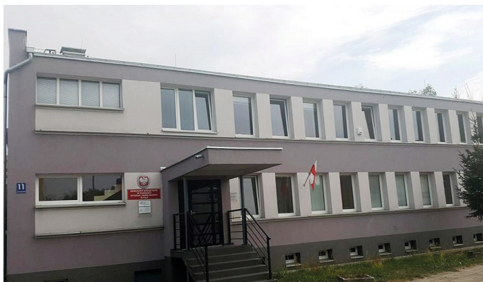
Rys. 4. Budynek Wydziału Zamiejscowego w Lesznie po termomodernizacji
