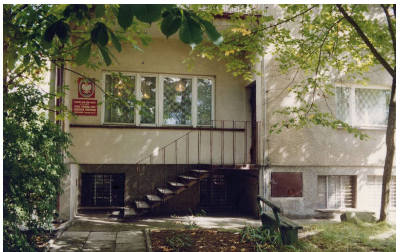
Rys. 4. Budynek Wydziału Elektroniki i Czasu OUM w Gdańsku, ul. Komandorska 26
