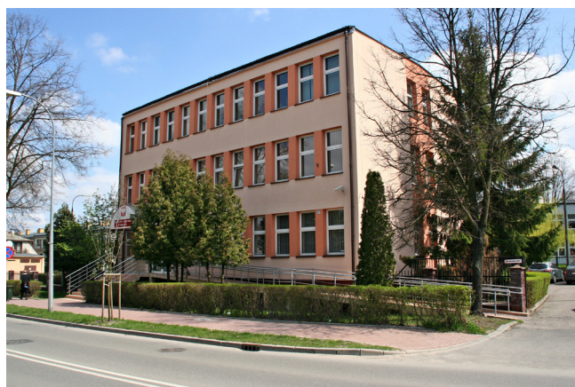
Budynek Obwodowego Urzędu Miar w Siedlcach
