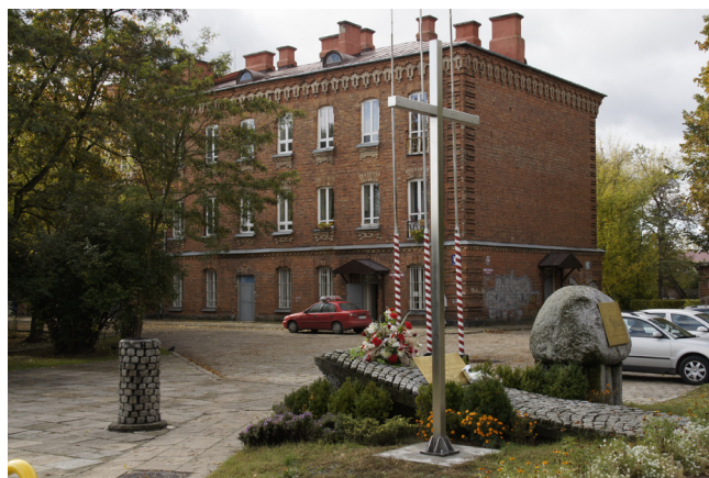
Budynek Obwodowego Urzędu Miar w Ostrołęce
