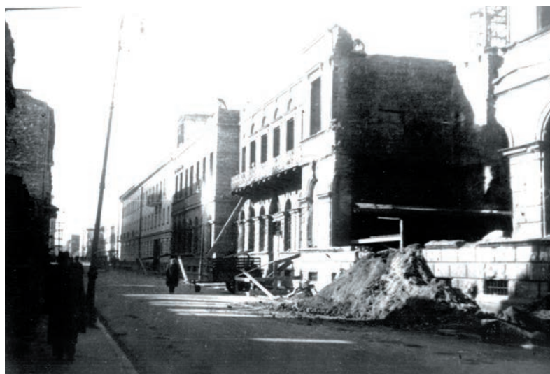
Wyrwa w elewacji budynku GUM spowodowana wybuchem bomby
