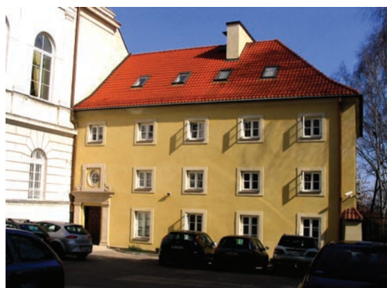
Krakowskie Przedmieście 66. Oficyna, w której mieściła się Stacja Sprawdzania Przyrządów Fizycznych. Stan obecny
