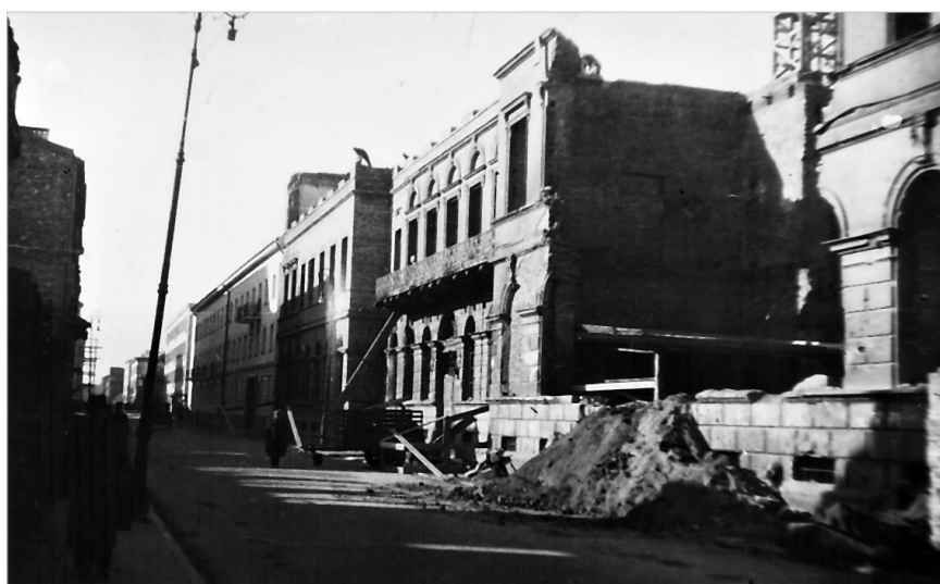
Ilustr. 1. Wyrwa w elewacji budynku GUM spowodowana wybuchem bomby
