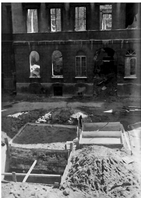
Ilustr. 8. Prace przy odbudowie gmachu GUM
