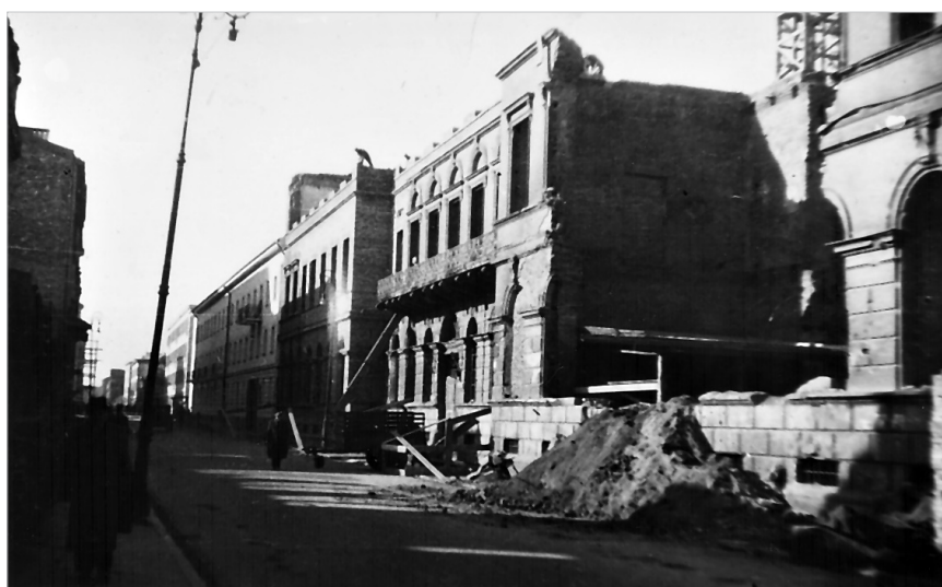
Ilustr. 1. Wyrwa w elewacji budynku GUM spowodowana wybuchem bomby
