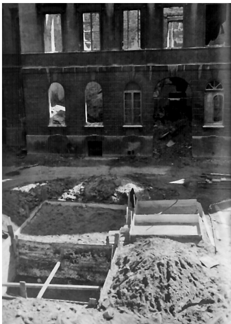
Ilustr. 8. Prace przy odbudowie gmachu GUM
