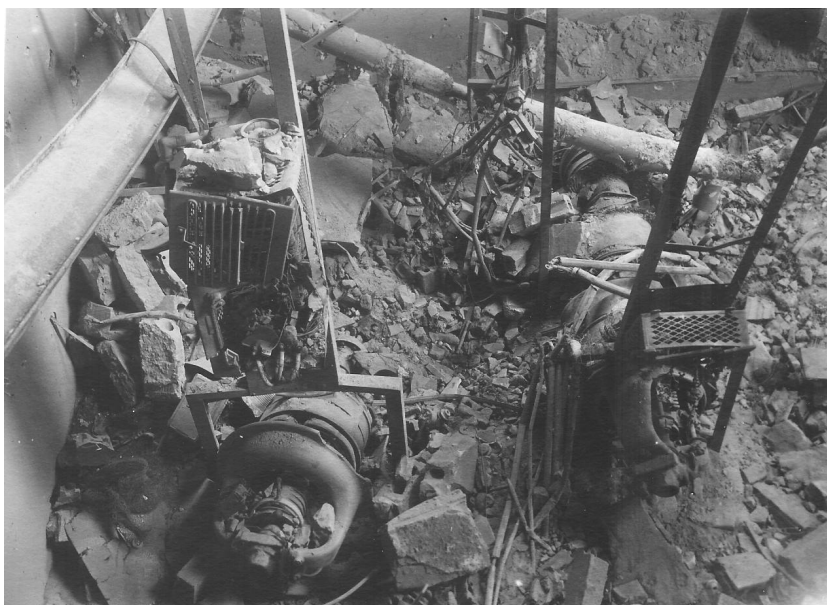
Ilustr. 2. Ruiny pracowni elektrycznej (1945). Na pierwszym planie zniszczone zespoły prądowórcze (Archiwum GUM)
