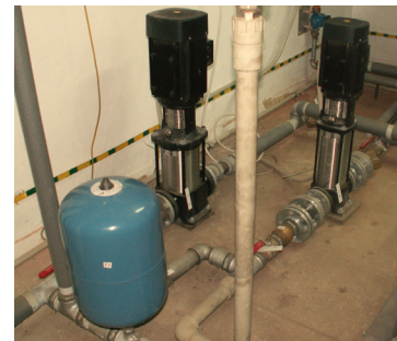
Zbiorniki magazynowe wody oraz układ pomp zasilających stanowisko
