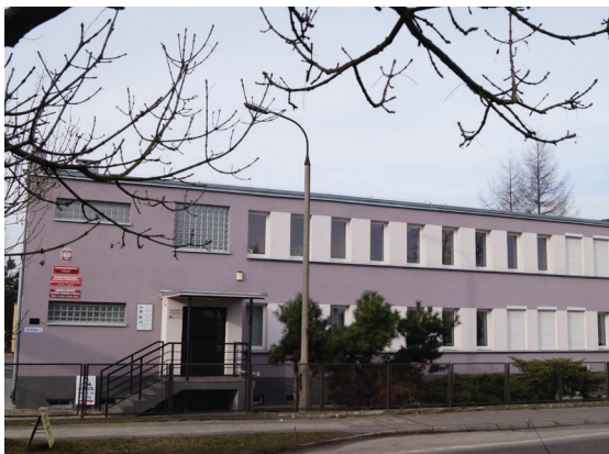
Fot. 1 Budynek biurowo-laboratoryjny Obwodowego Urzędu Miar w Lesznie po termomodernizacji
