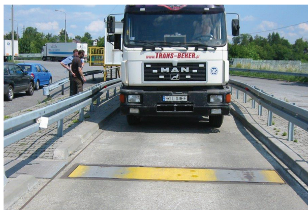
Rys. 1. Waga LS-WIM umożliwiająca ważenie pojazdów w ruchu przy szybkości przejazdowej poniżej 15 km/h
