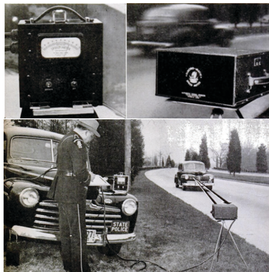
Fot. 9. Policyjny radar i zasada działania w praktyce, (źródło: „Popular Science”, czerwiec 1947 r.)
